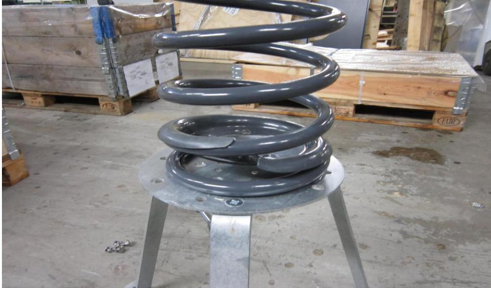
Kierrä kiinnityslevyä kohti kiinnitysalustaa.
